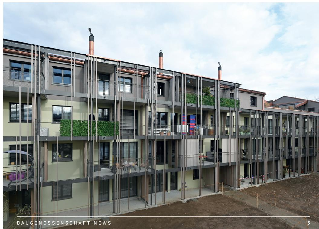
Herbst bereits rege genutzt wurden. Pro Balkon stehen zwei Vorhänge als Sicht- und Sonnenschutz zur Verfügung und können je nach Bedarf individuell platziert werden. Auf den Dachflächen sind Solarzellen montiert. Der damit tagsüber gewonnene Strom reduziert den Bezug aus dem öffentlichen Stromnetz.
